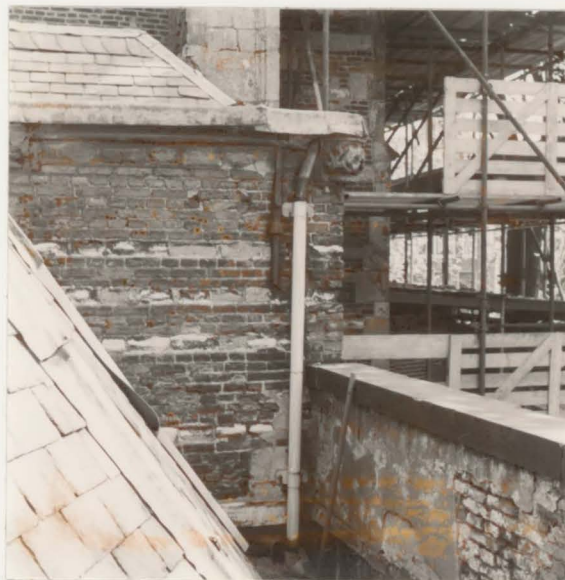
NEG.NO. 1706. WESTGEVEL GEZIEN NAAR HET ZUIDOOSTEN.
