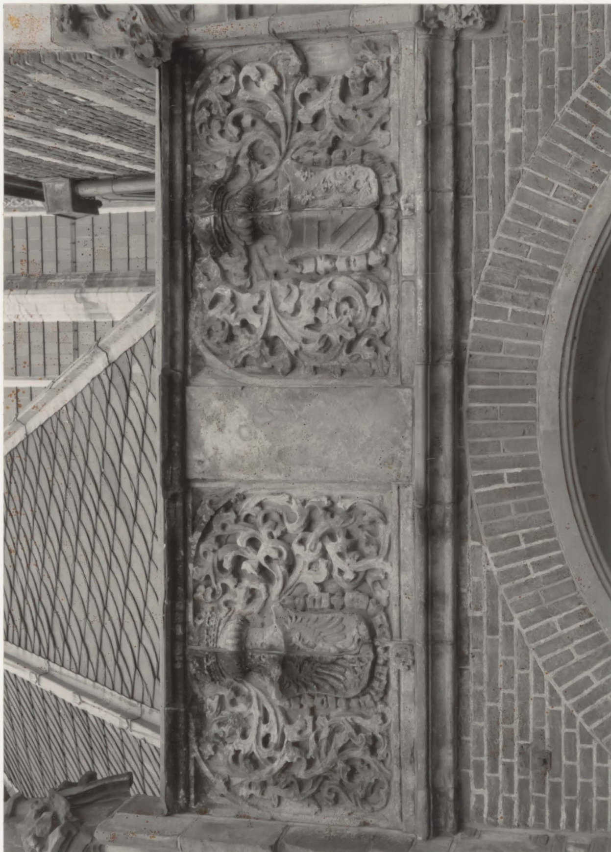
RESTAURATIE O U D E K E R K T E A M S T E R D A M BESCHRIJVING ZUIDERPORTAAL, LIBRIJE, IJZEREN KAPEL FRIES ZUIDERPORTAAL WAPENS MAXIMILIAAN EN PHILIPS DE SCHONE FOTO: R.C. NIEUWENHUIS JANUARI 1985 RESTAURATIEBUREAU NEG.NO. 1896
