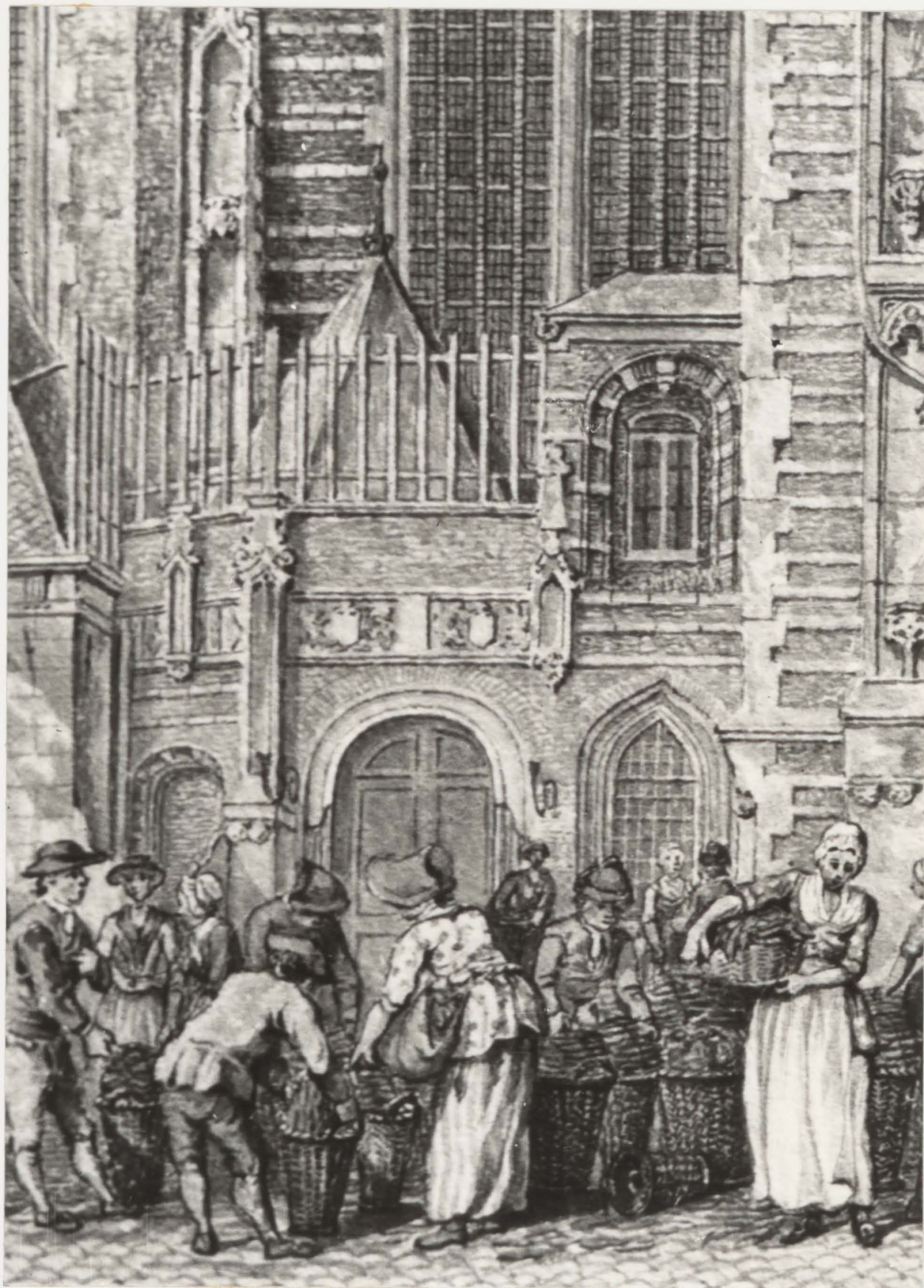
RESTAURATIE OUDE KERK TE AMSTERDAM BESCHRIJVING ZUIDERPORTAAL, LIBRIJE, IJZEREN KAPEL ZUIDZIJDE VAN DE OUDE KERK DOOR J. SCHOUTEN, 1778 FOTO: HIST.-TOPOGR. ATLAS GEMEENTEARCHIEF AMSTERDAM DETAIL NEG.NO. 20124
