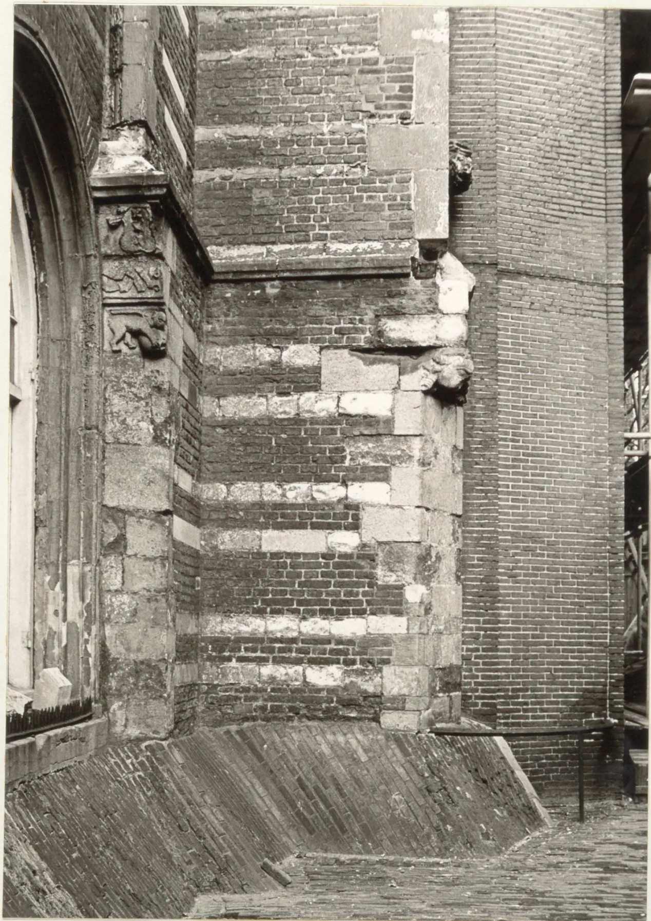
RESTAURATIE OUDE KERK TE AMSTERDAM BESCHRIJVING VAN DE SEBASTIAANSKAPEL. BENEDENDEEL VAN HET ZUID- WESTELIJK STEUNBEERPAAAR MET CONSOLES. FOTO: R.C.N. APRIL 1967
