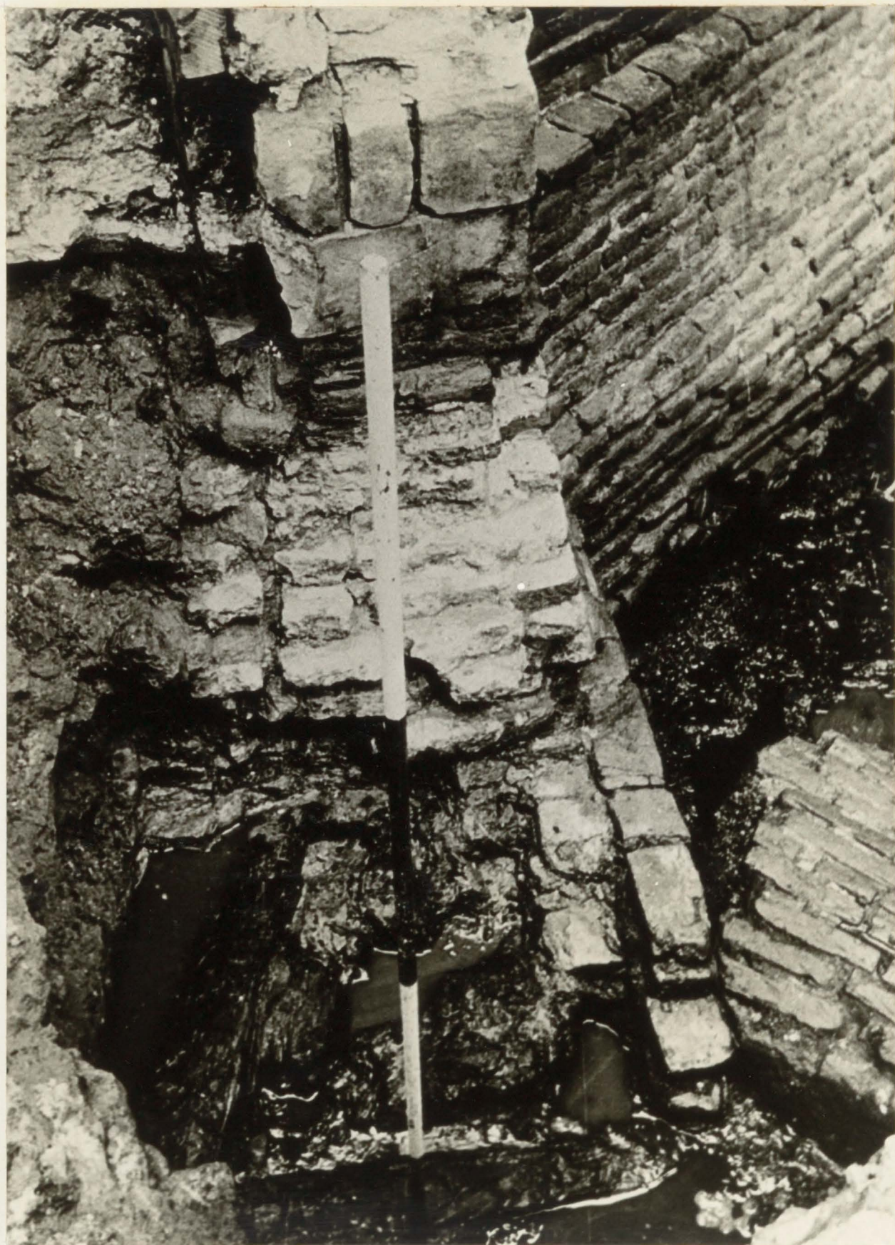
RESTAURATIE OUDE KERK TE AMSTERDAM BESCHRIJVING NOORDERPORTAAL EN HEILIG GRAF NOORDERPORTAAL FUNDERING STEUNBEER 110 GEZIEN UIT HET NOORDWESTEN FOTO: H.JANSE JULI 1955
